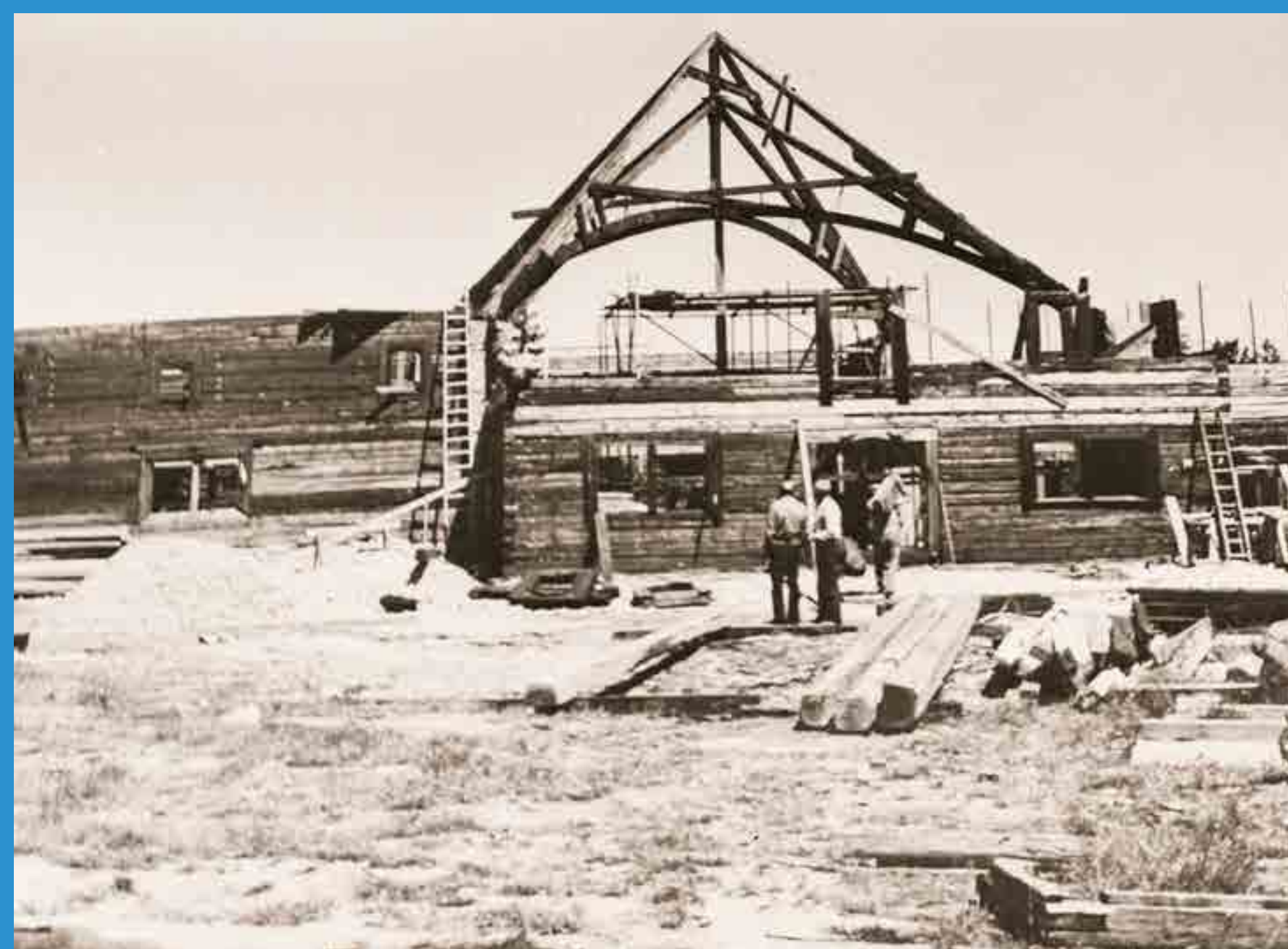
Demontáž artikulárneho kostola v Paludzi pred presťahovaním do Svätého Kríža
