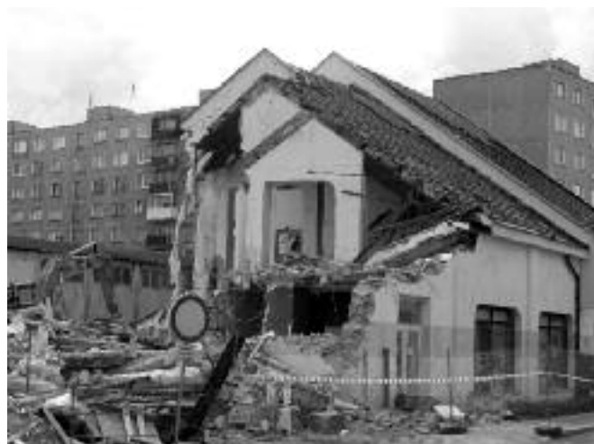
Z Mikuláša práve mizne ďalšia originálna budova. Asanácia bývalého Domu zeleniny.
